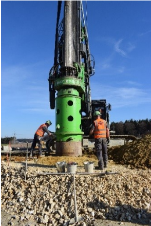
BW 7 Bohrpfahrlarbeiten für die Gründung
