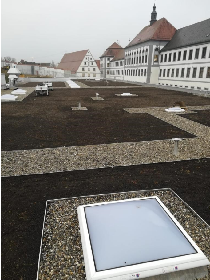
Technik, Licht, Oberflächen - der Blick vom Dach
