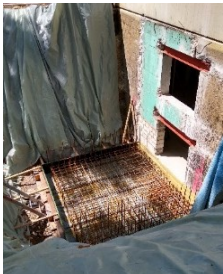
Fundament kombinierter Außen- und Fortlufturm
