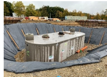
Einbringung Löschwassertank
