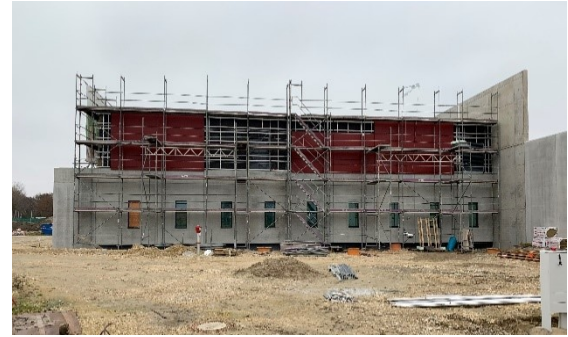
Montage vorgehängte Fassade
