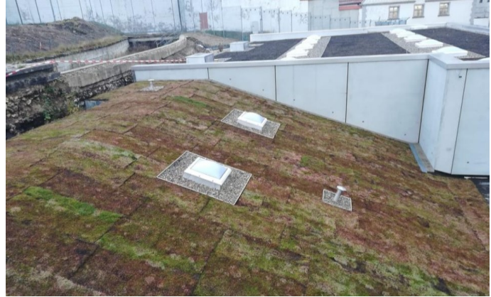
Begrüntes Dach zwischen den Nutzungen
