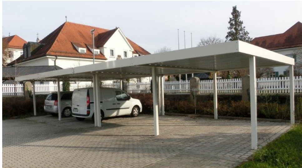
Neuer Carport neben Bestands-Carport, Ausführung baugleich
