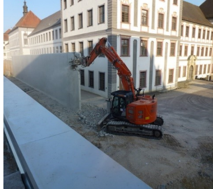
“Die Mauer muss weg”
