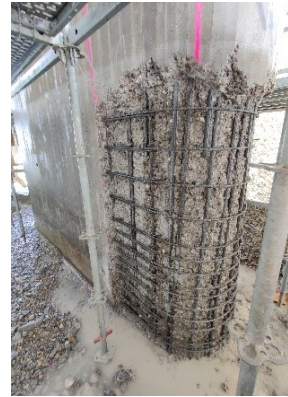
BW 518 Abtrag des geschädigten, chloridhaltigen Betons am Pfeiler
