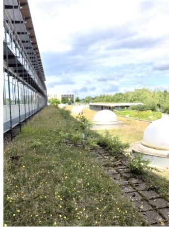
Sanierung der Lichtkuppeln
