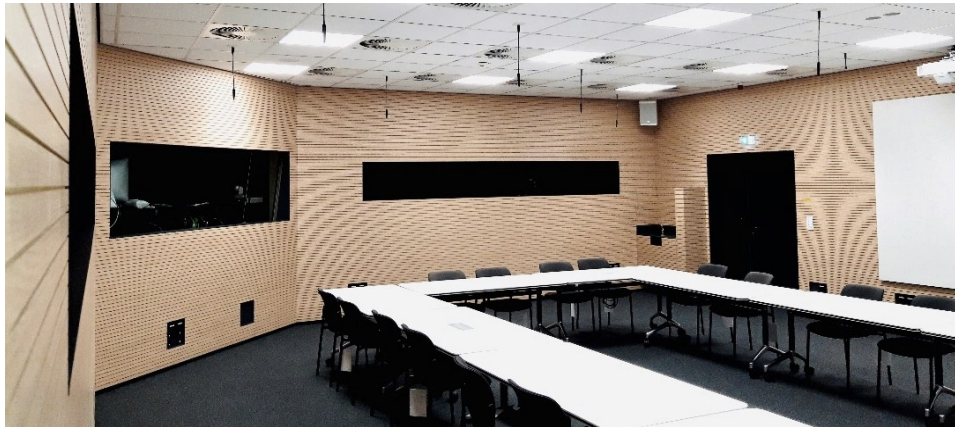
Mitschau nach der Medientechniksanierung
