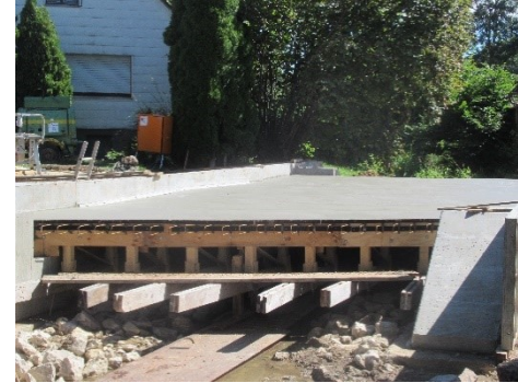
... nach Betonage der Ortbetonergänzung über den FT
