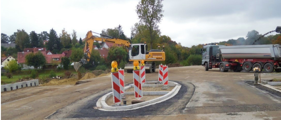
Der neue Geh- und Radweg entsteht – an seinen Enden ermöglichen Mittelinseln das sichere Queren der Fahrbahn
