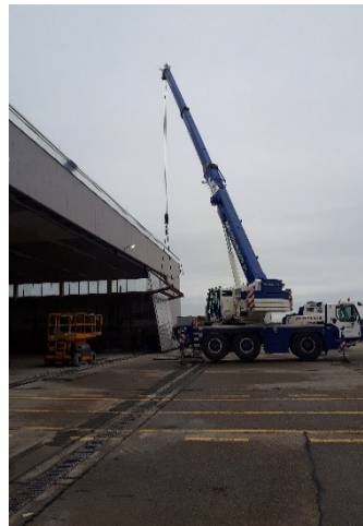
Einbau neue Tore in Hangar
