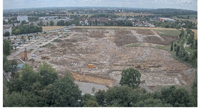
Kamerabild vom Baufeld des neuen Medizinischen Campus (Juli 2020)
