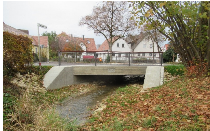
Nach Fertigstellung im November 2020
