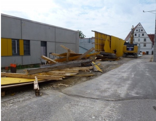
Aus zwei mach eins – Abbruch der Provisorischen Anstaltsmauer
