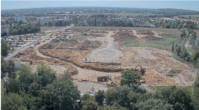
Kamerabild vom Baufeld des neuen Medizinischen Campus vom (August 2020)
