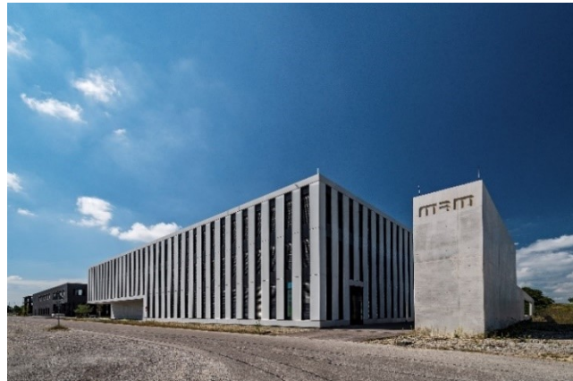
Hauptgebäude und Versorgungsbauwerk
