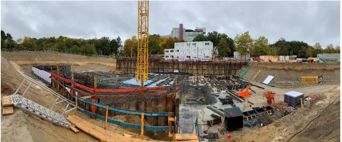
Bodenplatte LGB mit Frischbetonverbundfolie
