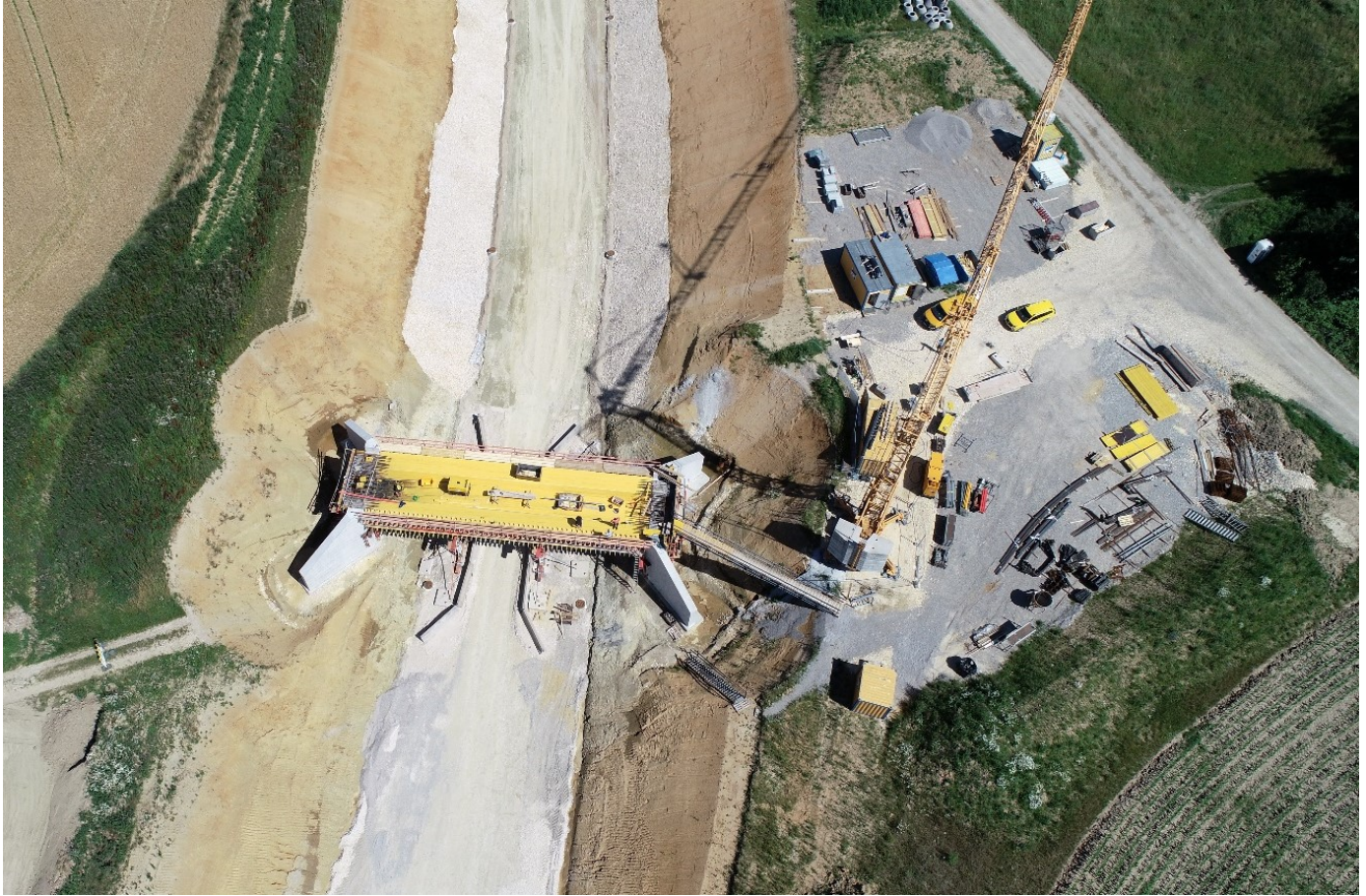
Bauwerk 12 nach Herstellung der Schalung für den Überbau und Baustelleneinrichtung
