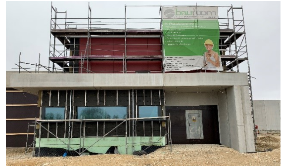
Montage vorgehängte Fassade
