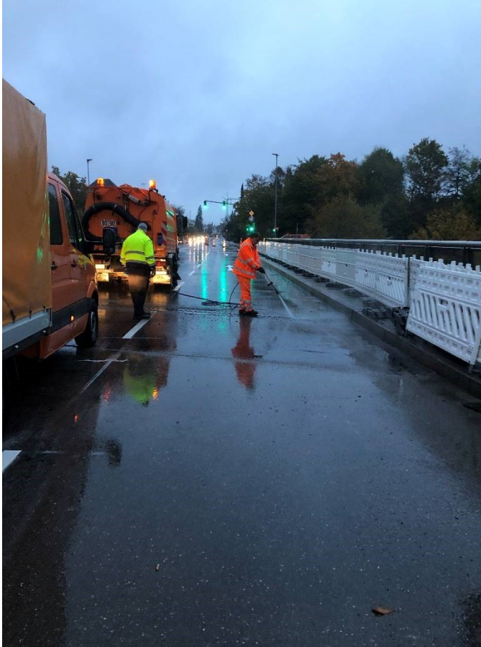
Reinigen einer ÜKO mit Hilfe einer Kehmaschine nach erfolgter Brückensanierung
