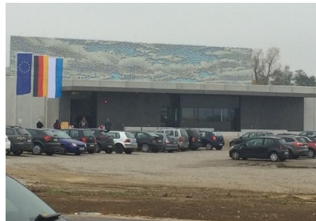
Hauptzugang, mit unbefestigten Flächen
