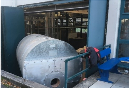
Ausbringung des Bestandskessels
