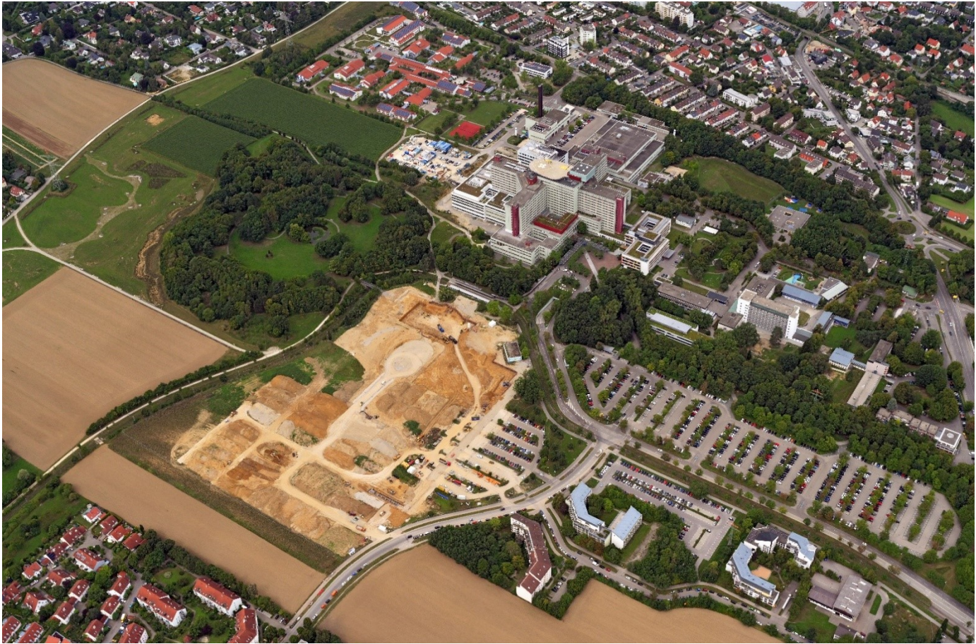
Luftbild vom Beginn der Erdarbeiten im August
