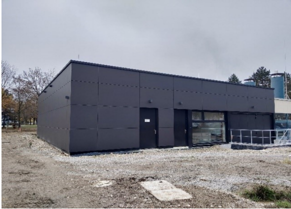
Neue Gebäudeerweiterung der Technikzentrale
