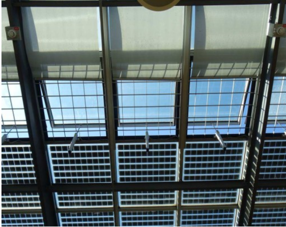
Erneuerung RWA- Spindelantriebe
