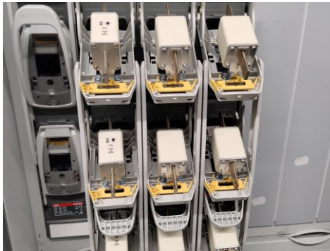
Niederspannungs-Hochleistungs-Sicherungen (NH- Sicherungen)
