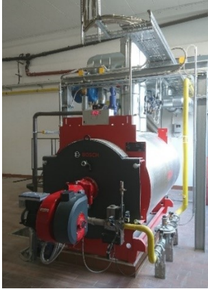
Zusätzlicher 700 kW-Gaskessel
