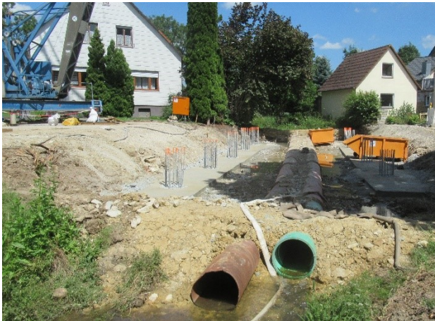
Baufeld samt Gründungsbauteilen mit Anschlussbewehrung und temporärer Verrohrung des Gänsbaches
