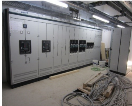
Niederspannungshauptverteilung (NSHV)
