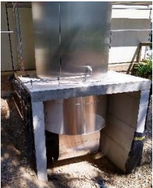
Fundament kombinierter Außen- und Fortlufturm
