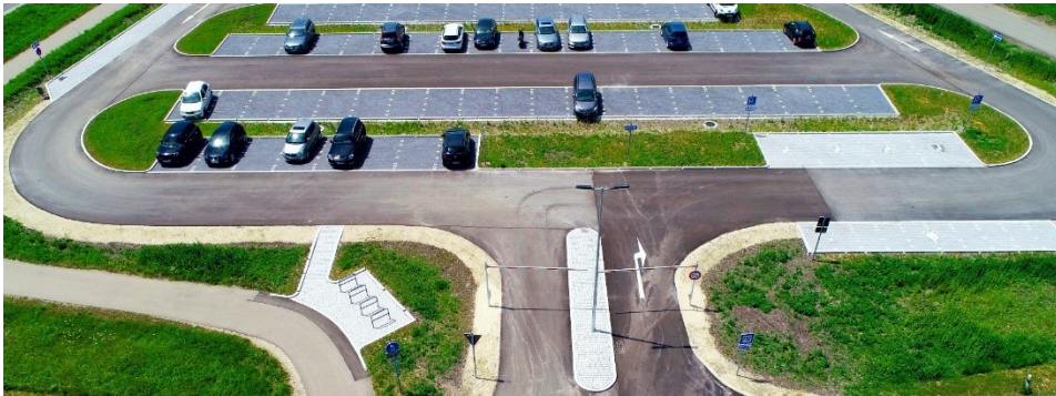
P+M - Platz kurz nach Fertigstellung – die ersten Verkehrsteilnehmer nutzen ihn bereits
