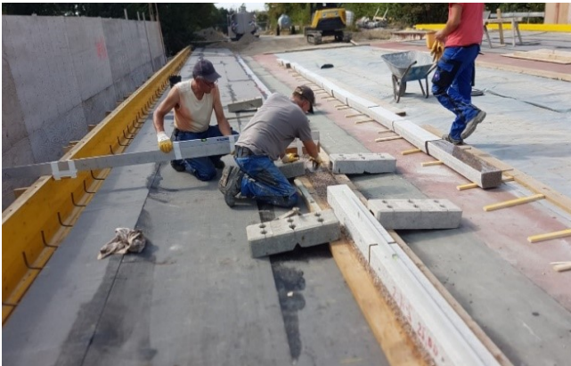
BW 518 Setzen der Bordsteine auf Einkornbeton mit Epoxidharz als Bindemittel
