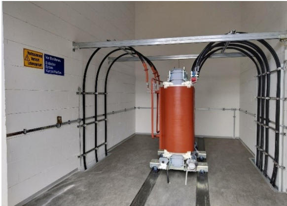
Mittelspannungstransformator 650 kVA
