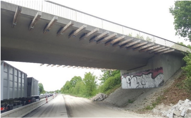
BW 518 Teil des Trag-/Arbeitsgerüsts, außerhalb des Verkehrsraumes hergestellt
