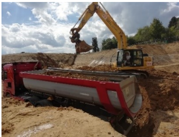
Eindrücke von der Baustelle
