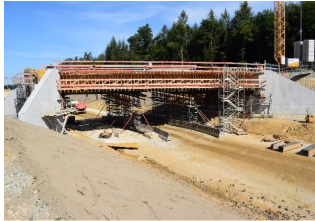
BW 7 Fertiggestelltes Traggerüst für die Überbauschalung mit gesicherter Durchfahrt für Baustellenfahrzeuge
