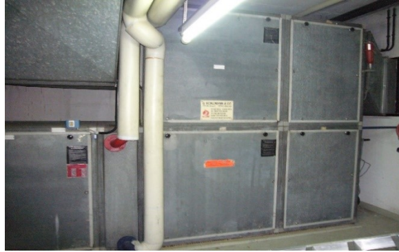
Vorher: Zuluftanlage Schwimmhalle ohne Wärmerückgewinnung
