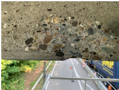
Betonabtrag für Instandsetzung eines Anprallschadens am Überbau
