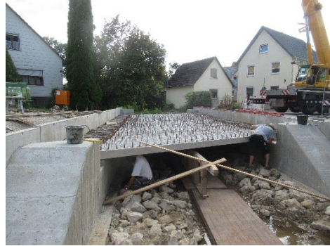
Überbau nach Einheben der Fertigteile (FT) und...
