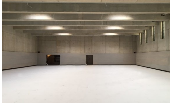
Blick in die fast fertige Sporthalle
