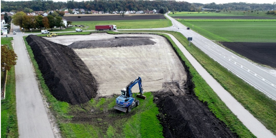
Oberbodenabtrag zu Beginn der Maßnahme
