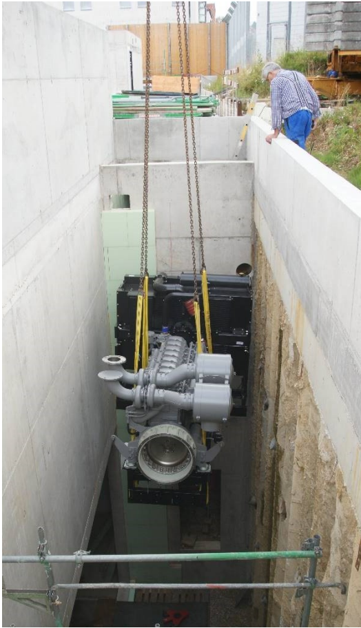
Entwicklungsprozess vom Einbringen des Dieselmotors bis hin zur fest verbauten Netzersatzanlage (NEA)
