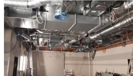
Bestandsinstallationen und neue Installationen
