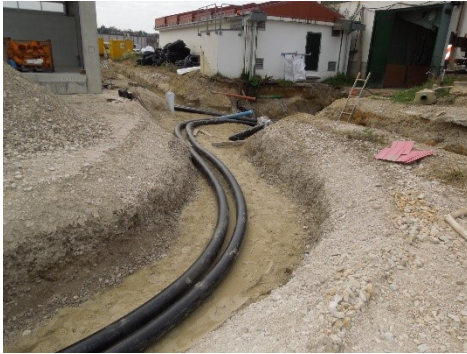
Erschließung Nahwärme: Verlegung flexibles Stahlmantelrohr (ca. 800 m) aus Heizzentrale (Bestand) zu den neuen Gebäuden
