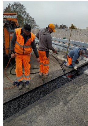
BW 517 Herstellung des bituminösen Fahrbahnüberganges
