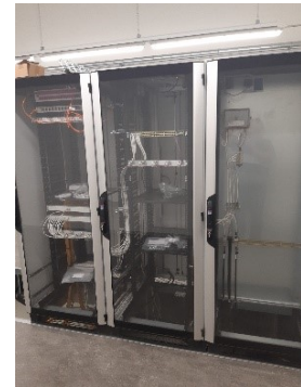
Datenverteilerschränke (unbestückt)
