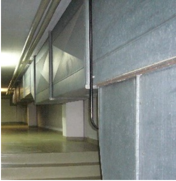
Alte Kanalführung Schwimmhalle
