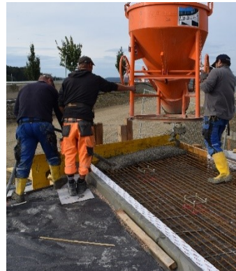
BW 7 Beginn der Kappen-Betonage
