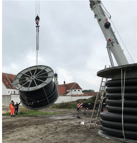
Trommelanhänger 6,7 t Trommel bestückt 4,9 t Trommel leer 2,4 t
