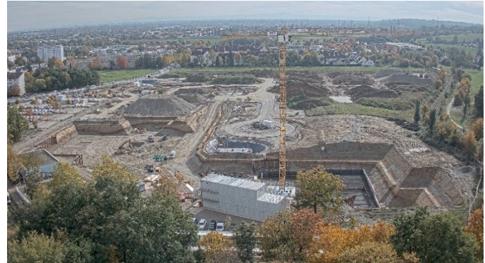
Kamerabild vom Baufeld des neuen Medizinischen Campus vom (Oktober 2020)
