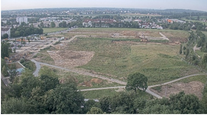
Kamerabild vom Baufeld des neuen Medizinischen Campus (Juni 2020)
