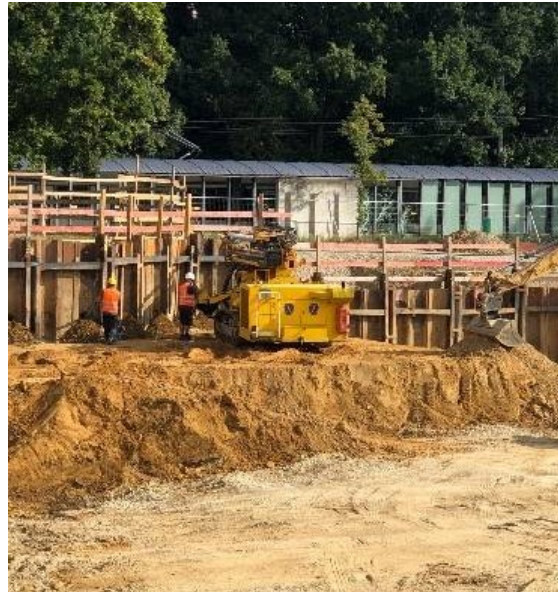
Verbauarbeiten LGB mit Kampfmittelsondierung
