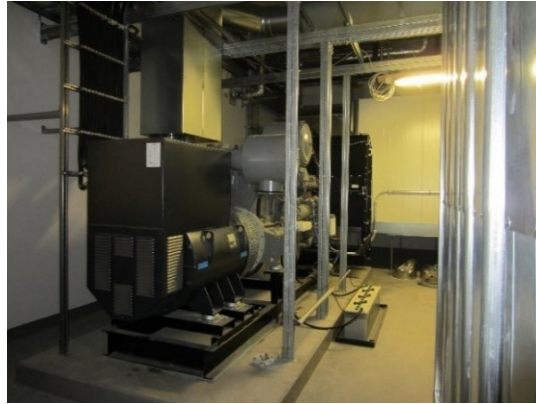
Entwicklungsprozess vom Einbringen des Dieselmotors bis hin zur fest verbauten Netzersatzanlage (NEA)
