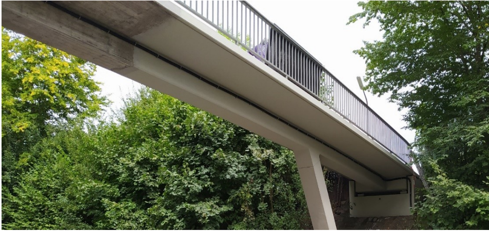
Beschichtung der Betonoberfläche des sanierten Bauwerkes
