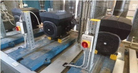
Ausgetauschte Netzpumpen
