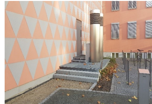
Einbau zus. Fluchttür aus Hörsaal
