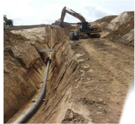
Rohrverlegung im vorbereiteten Rohrgraben
