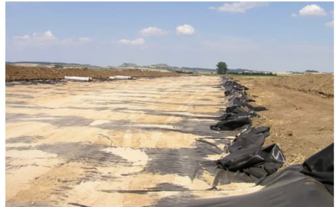
Verlegen von Geokunststoffen zur Gewährleistung der Standsicherheit
