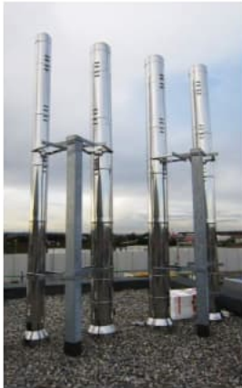
Kaminanlagen auf Dach
