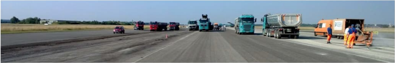
Fräsarbeiten: Feinfräsen der ersten Lage (hoch PAK-belasteter alter Anti-Skid-Belag), Grobfräsen der zweiten Lage (Asphaltdeckschicht), Abtransport mittels Lkw
