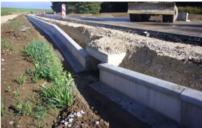
Bau der Leiteinrichtung und Querung für Amphibien
