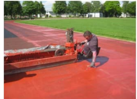
Fertiger für Kunststoffbelag
