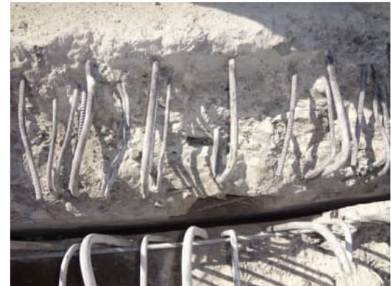
Freigelegter Übergang Brücke-Strecke
