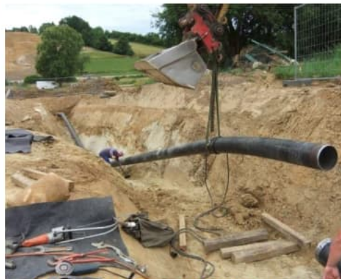
Anschluss Tieferlegungsabschnitt an Rohrbestand (rechts)
