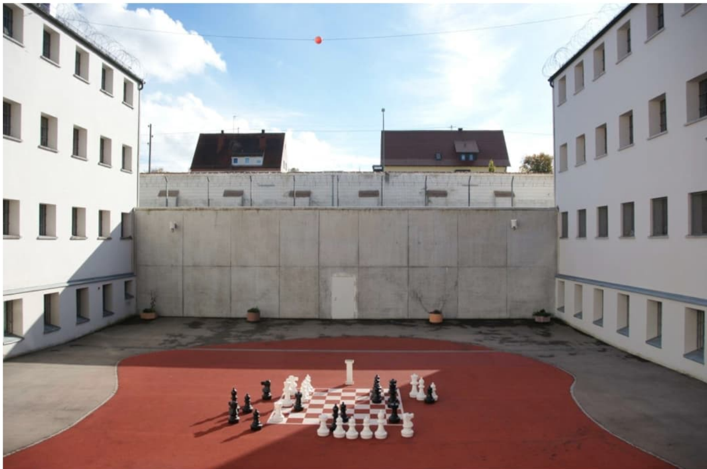
Innenhof des Zellengebäudes mit 2 Antennen an der Betonmuer
