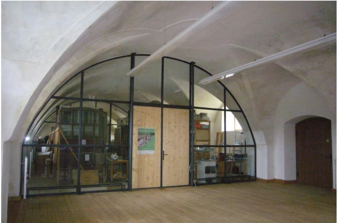
Stahl-Glas-Elemente im Ökonomiegebäude Ost
