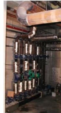
Wärme-Hauptverteiler
