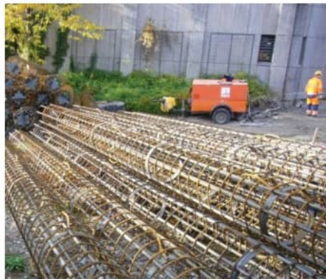
Bohrpfahlbewehrung
