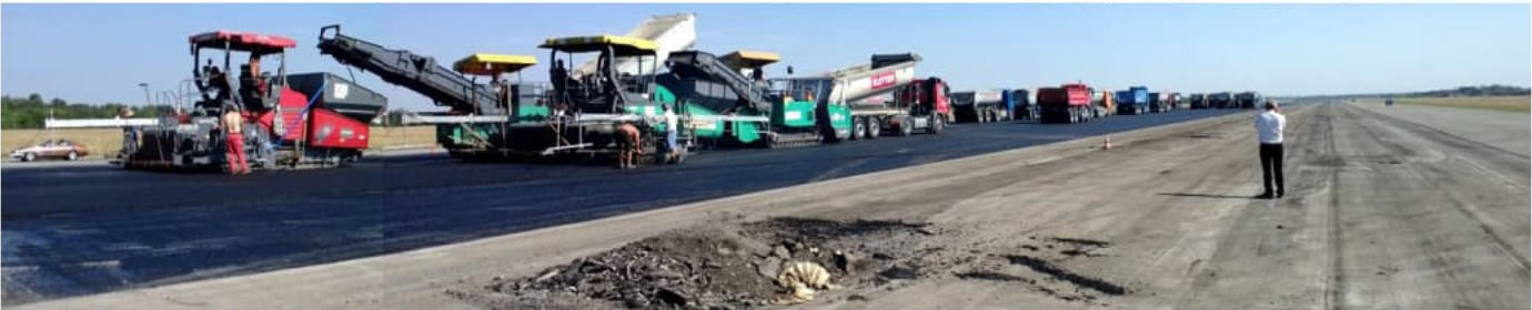
Asphaltarbeiten für zwei Bahnen à 7,5 m „heiß in heiß“: Walze (nicht im Bild), Asphaltfertiger, Beschicker, Mischgutanolieferung durch Lkw's
