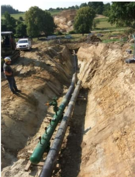
Temporär angebaute Molchschleuse zur Wasserspülung/-Druckprüfung (ca. 140 bar)
