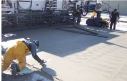
Glätten der Betonoberfläche
