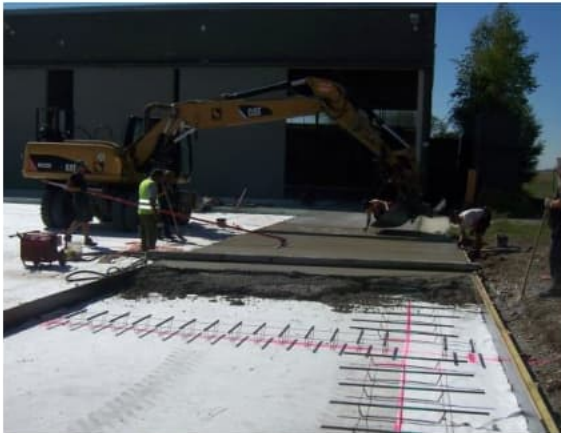
Handeinbau, Glätten, Besenstrich
