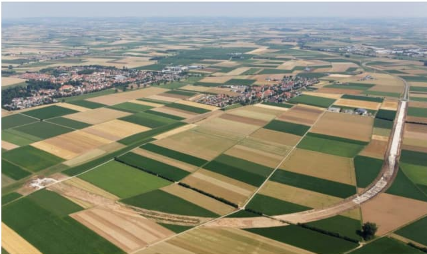
Beginn der Oberbodenarbeiten aus der Vogelperspektive
