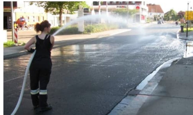
Kühlung für den neuen Fahrbelag bei der Feuerwehrübung
