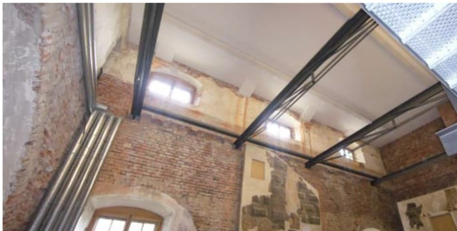
Eingezogene Decke in der Werkstatt Mauerwerk/Wand/Stein
