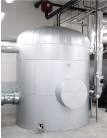
Pufferspeicher mit 9 m3 Inhalt
