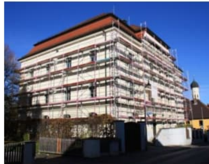
Nord-Ost-Ansicht während Sanierung
