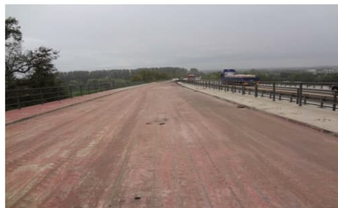
Fahrbahntafel nach Rückbau von Belag, Abdichtung und Schutzeinrichtungen
