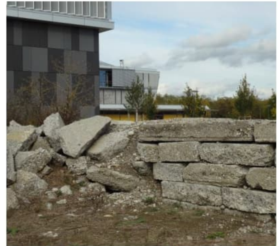
Betonbruch und zu Mauern geschichtete Betonklötze als neue Habitatstrukturen für Eidechsen und weitere Kleintiere
