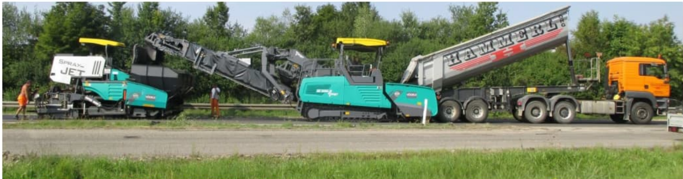
Asphalteinbauzug: Asphaltfertiger, Nachmischbesicker und Sattelschlepper
