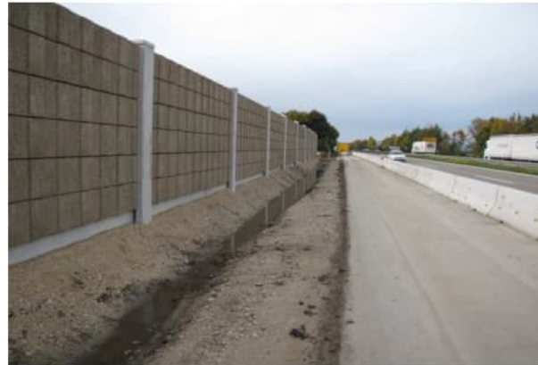
Neue Holzbetonwandelemente mit Stahlbetonstützen
