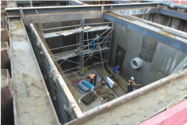
Die neue Entwässerungsanlage mit Kanalleitungen, Pumpwerk und Regenrückhaltebecken entsteht
