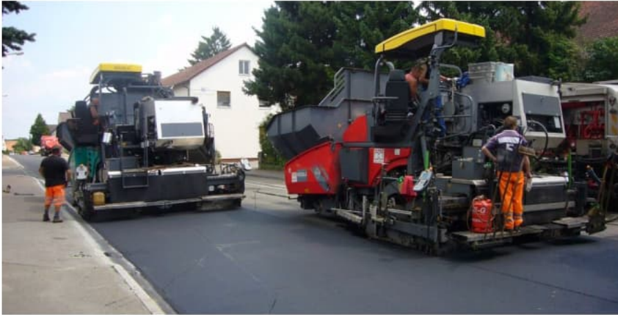
Einbau des lärmindernden DSH-V mit zwei Sprühfertigern
