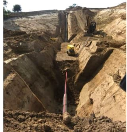
Wiederverfüllung (lageweise Verdichtung) des Rohrgrabens
