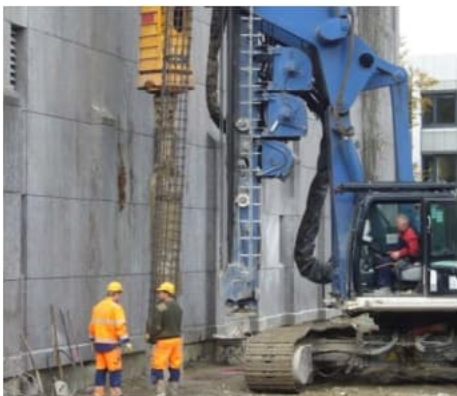
Bohrpfahlarbeiten
