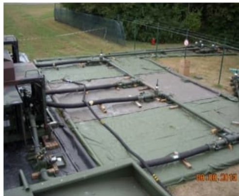
Aufbau der mobilen Hochdruckpumpstation der Bundeswehr-Pioniere zur Wiederbefüllung der Fernleitung
