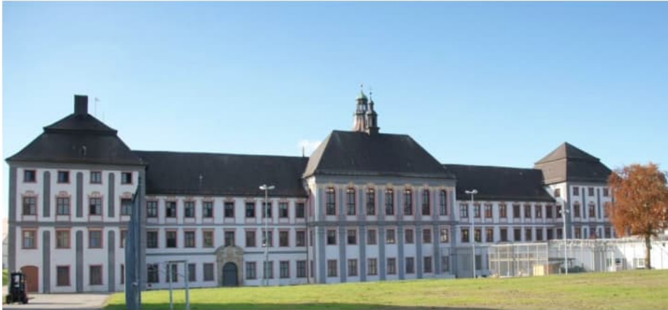
Das Hauptgebäude der JVA Kaisheim: Eine ehemalige Abtei aus dem frühen 18. Jahrhundert
