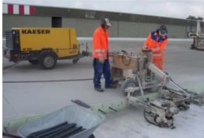
Setzen der Dübel (Anschlußbewehrung an Bestand mittels Raumfuge)
