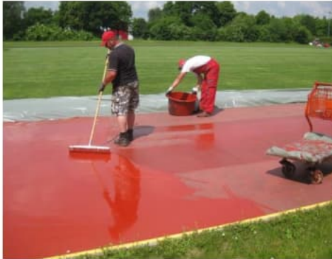
Einbringen des Tartanbahnbelags
