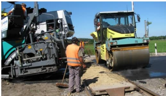
Detailarbeit beim Anschluss an die Staudenbahnquerung
