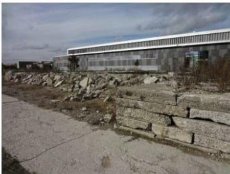
Bestehende Betonplattenwege des ehemaligen Flugfelds Haunstetten wurden in das Gestaltungskonzept integriert oder als Trockenmauern geschichtet neu verwendet
