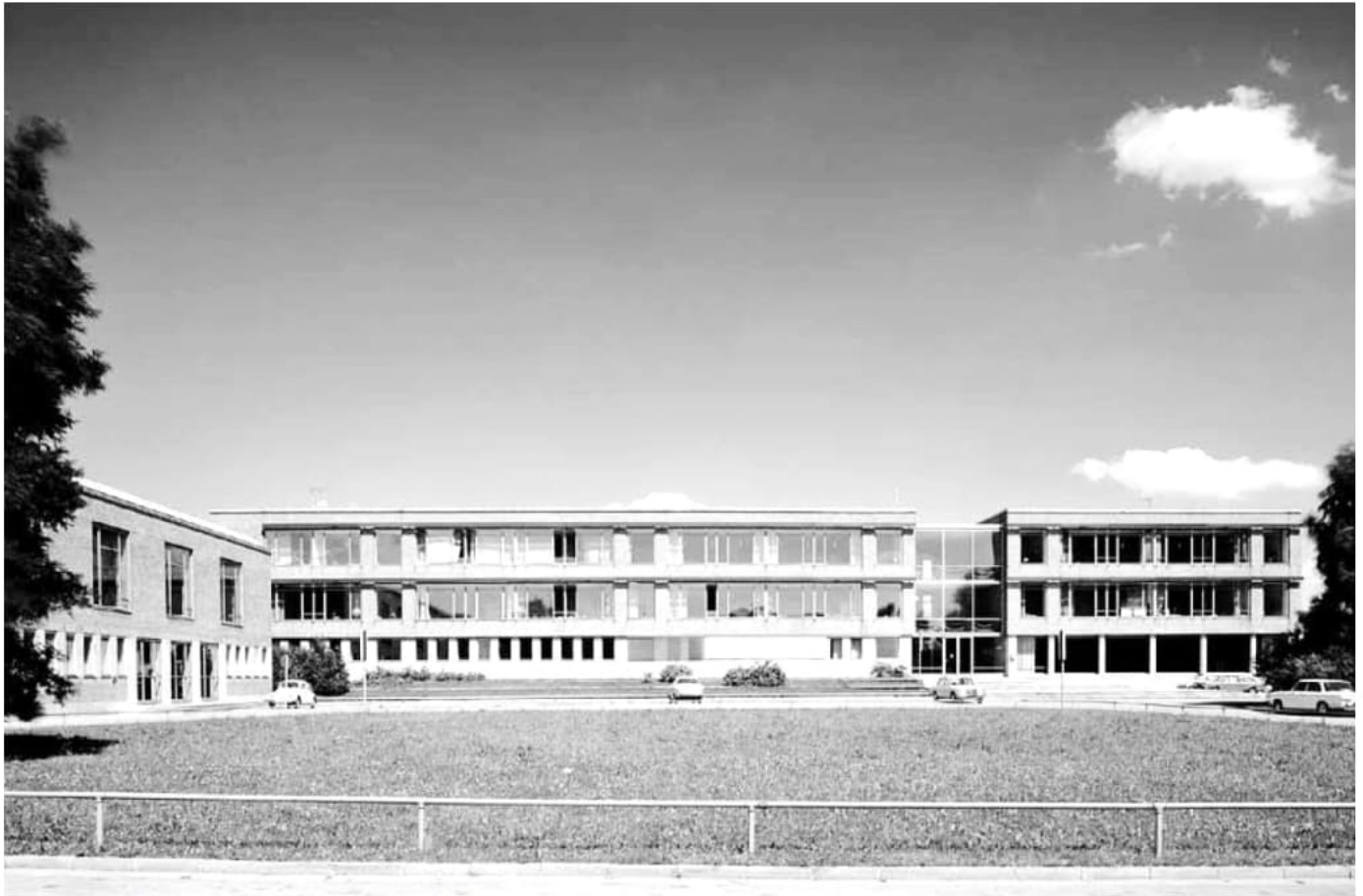
Ansicht ehemalige Pädagogische Hochschule von Westen, Eigenplanung des ehem. Landbauamtes
