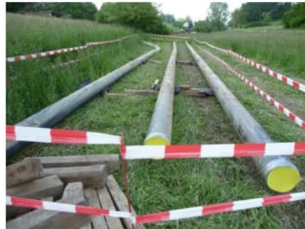
Ausgebaut für den Wiedereinbau gesicherte Rohrleitungsstücke
