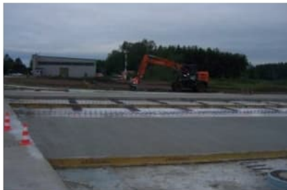
Zwei frisch betonierte Bahnen
