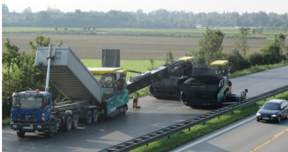
Gestaffelter Einbau des lärmarmen Fahrbahnbelags mit zwei Asphaltfertigern
