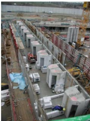
Hafthflügel im Bau
