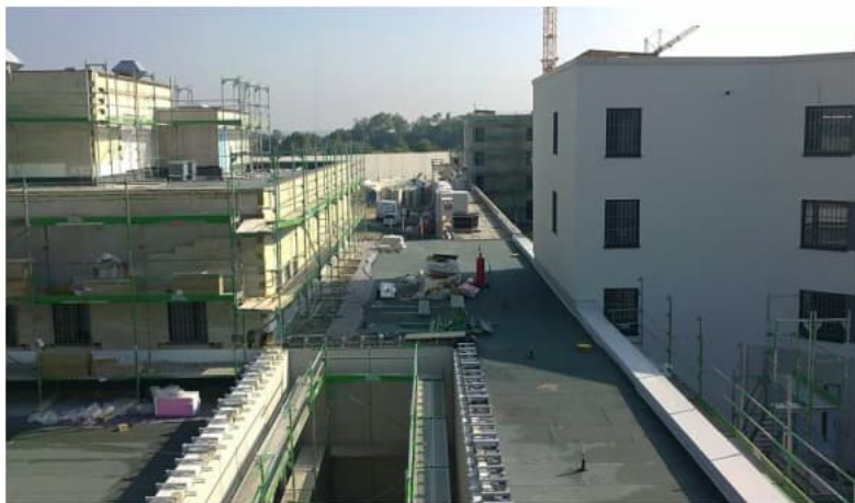
Magistrale mit Hafthäusern und Versorgungsgebäude
