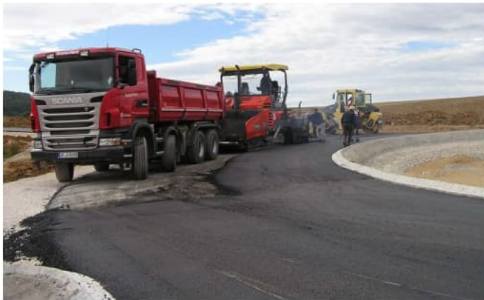
Einbau der Asphalttragschicht
