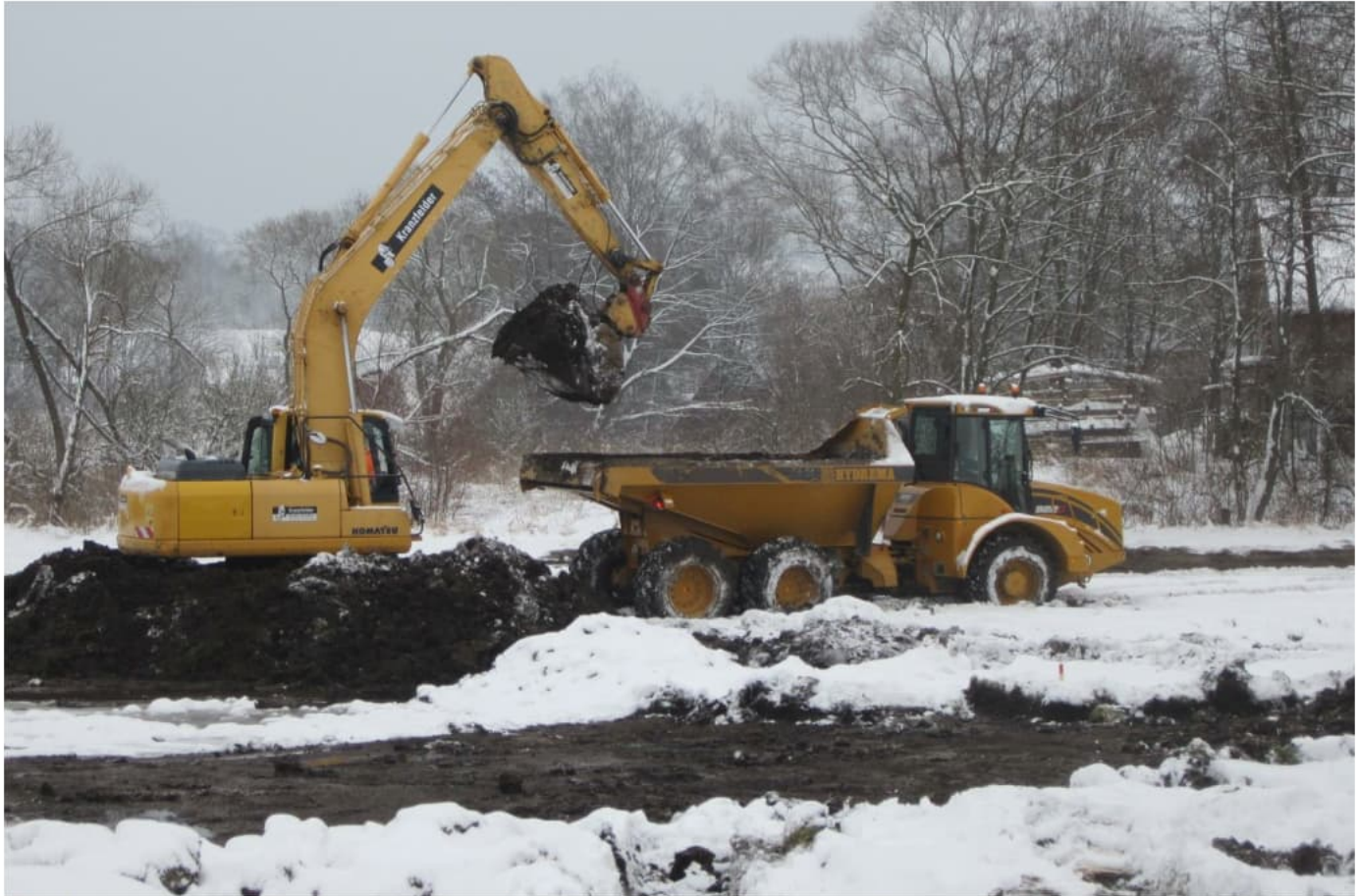
Herstellung von naturschutzfachlichen Ausgleichflächen und Retentionsraum für den Hochwasserschutz bei widrigen Wetterbedingungen
