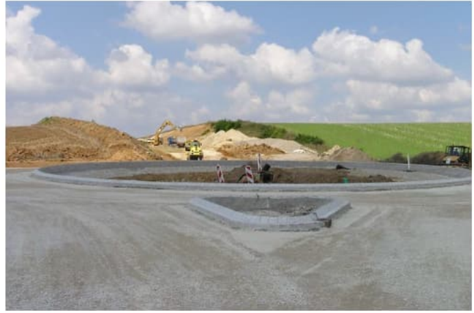
Kreisverkehr im Rohbau
