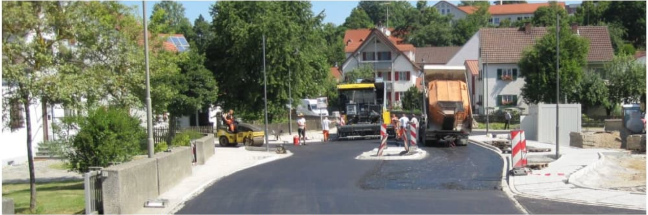
Beseitigung der Engstelle beim ehemaligen Gasthof Schaller während der Bauarbeiten
