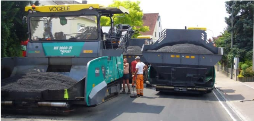
Andienung der Sprühfertiger mit einem Beschicker
