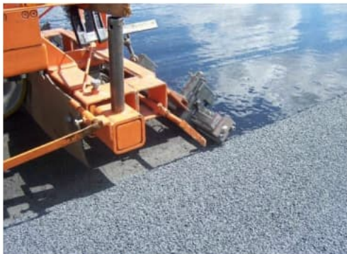
Aufbringen des Zwei-Komponenten-Harzes
