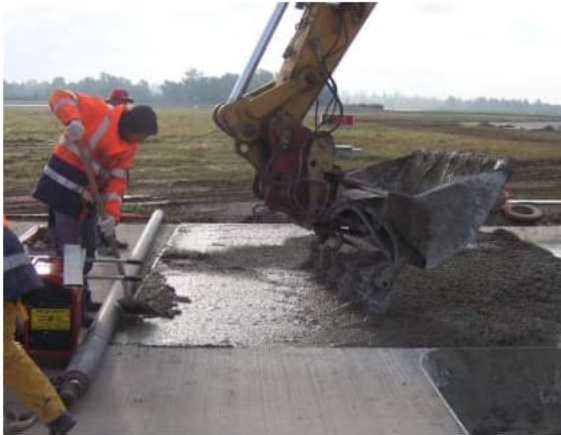
Handeinbau, Rüttelschaufel
