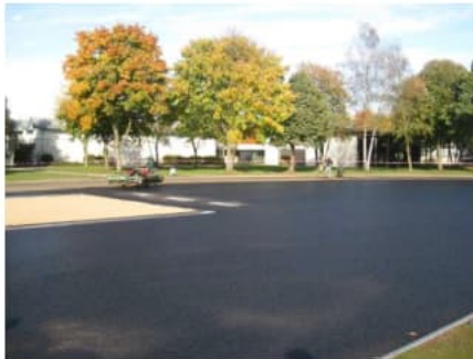
Asphaltierung der Flächen
