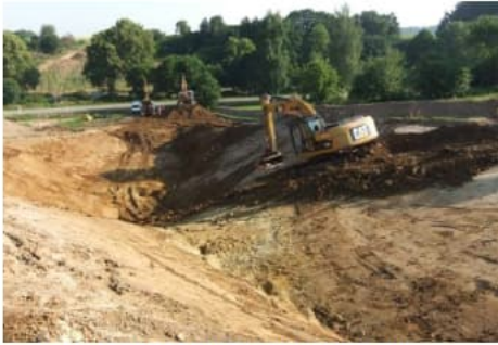
Vorlaufende Geländemodellierung durch Dritte -im Auftrag des Staatlichen Bauamtes Krumbach- für künftiges Straßenkörperprofil
