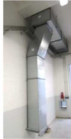
Verbrennungsluft-Zuführung
