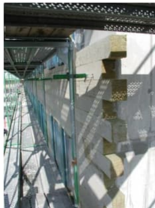
Wärmedämmverbundsystem
