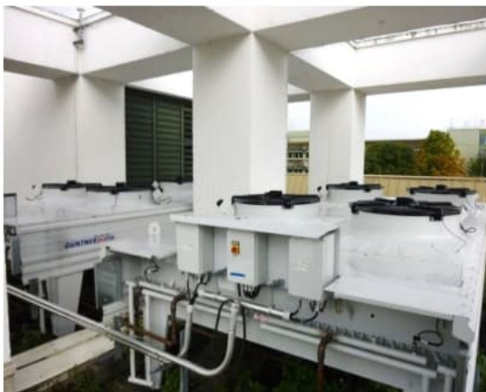
Trockenrückkühlwerke
