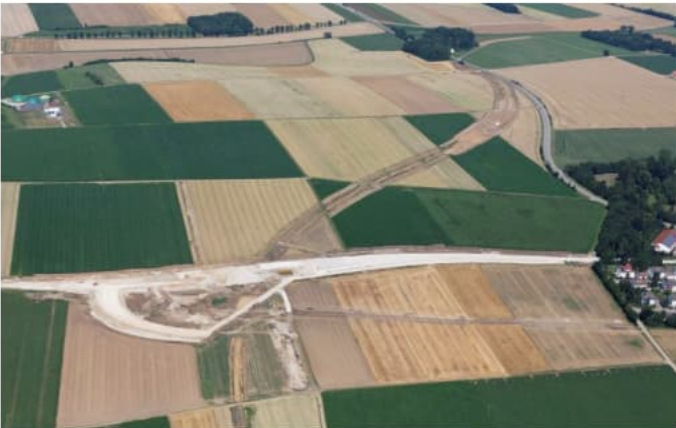
Beginn der Arbeiten an der Anschlussstelle mit der St 1060
