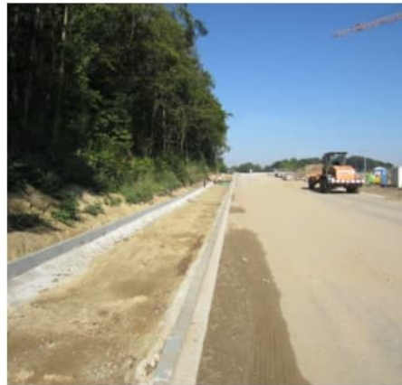
... und auch die Kreisstraße erhält ein Gesicht
