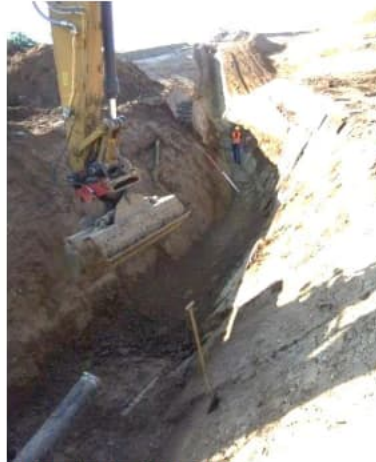
Rohrgrabenherstellung nach Geländemodellierung
