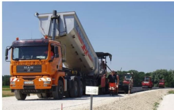
Einbau der Asphalttragschicht
