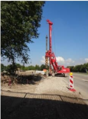
Bohrpfahlarbeiten
