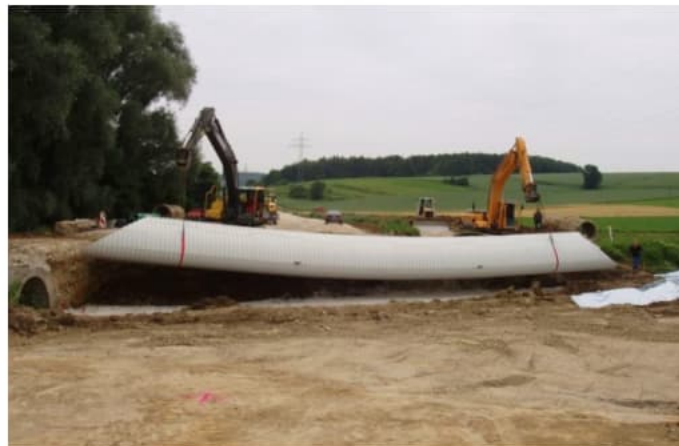
Einheben des Wellstahldurchlasses
