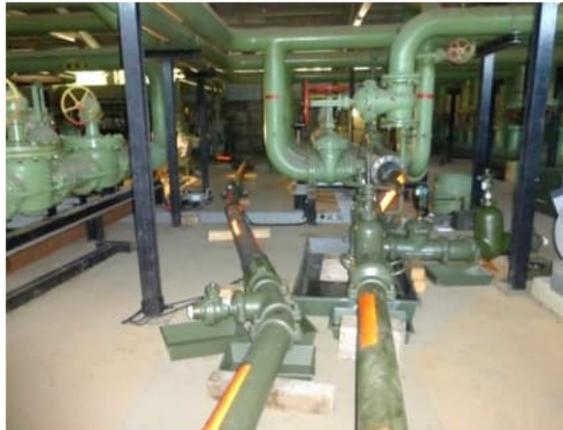
Anbindung v von Saug- bzw. Druckleitung im Manifold
