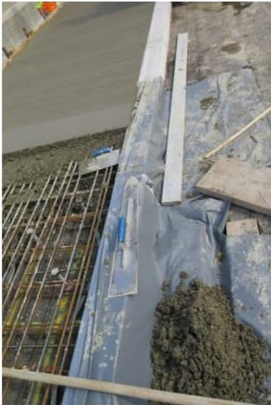
Einbau des Kappenbetons mit Besenstrich
