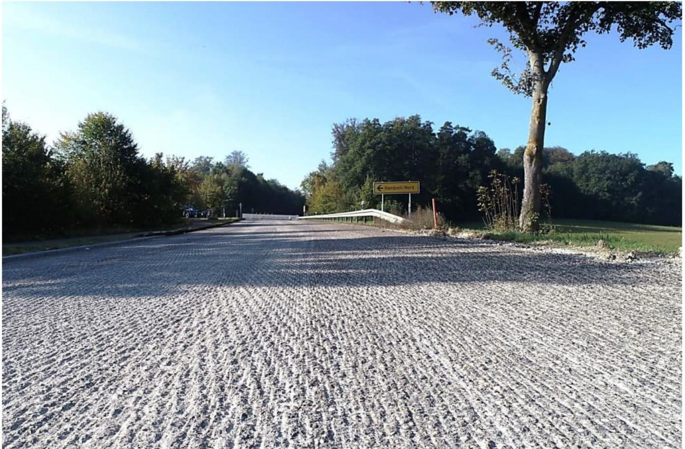
St 2035 zwischen Pöttmes und Handzell – gefräste und gereinigte Asphaltfläche vor dem Einbau der neuen Deckschicht
