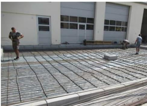
Einbau einer engmaschigen Bewehrung
