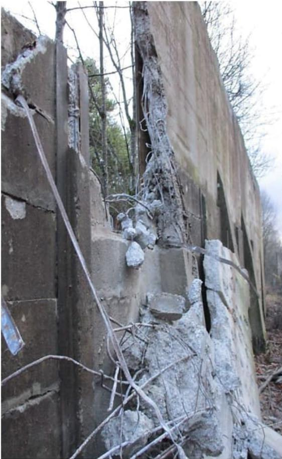
Abbruch der freistehenden Stahlbetonwand
