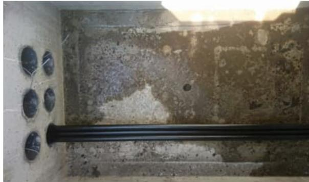
Mittelspannungskabel für den 3. Ring im Kabelleerrohr verlegt
