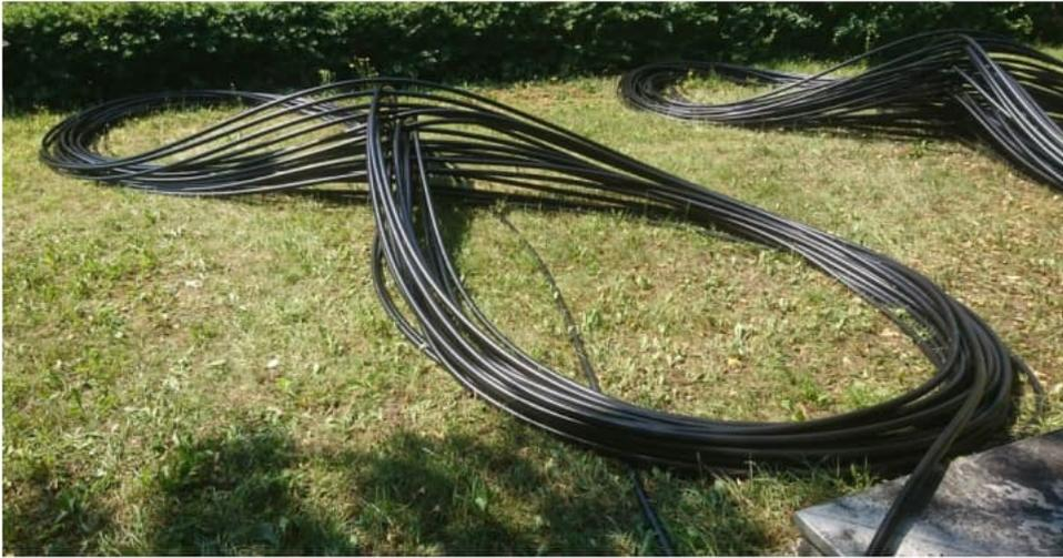
Mittelspannungskabel für den 3. Ring vor der Verlegung in Kabelleerrohre
