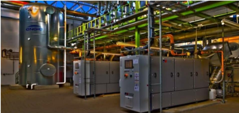
Heizzentrale mit neuinstallierten Blockheizkraftwerken
