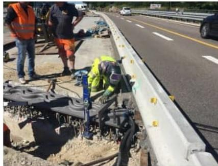
Enge Einbaubedingungen für die Übergangskonstruktion zwischen Brücke und Strecke neben der halbseitigen Verkehrsführung
