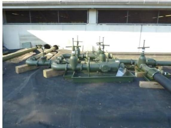
Schmutzfänger in der Saugleitung sowie Druckleitung von u. zu Manifold
