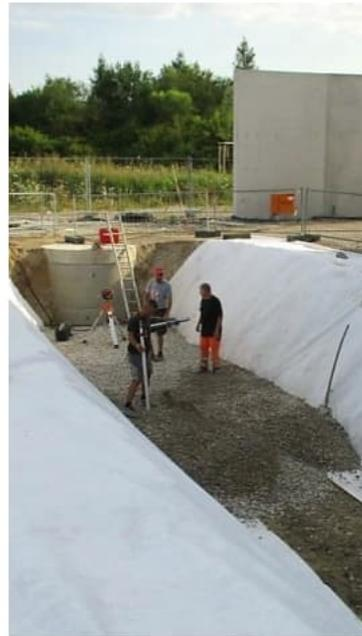
Errichtung einer Rohr-Rigolen-Versickerung vor dem Gebäude für Materials Resource Management (MRM)
