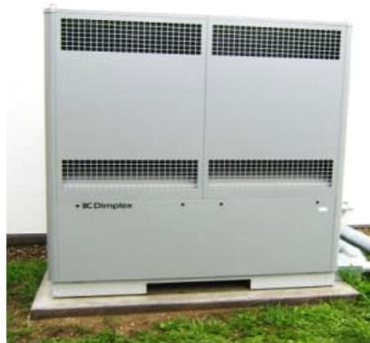
Wärmepumpenaußeninheit zur Rücklaufsenkung
