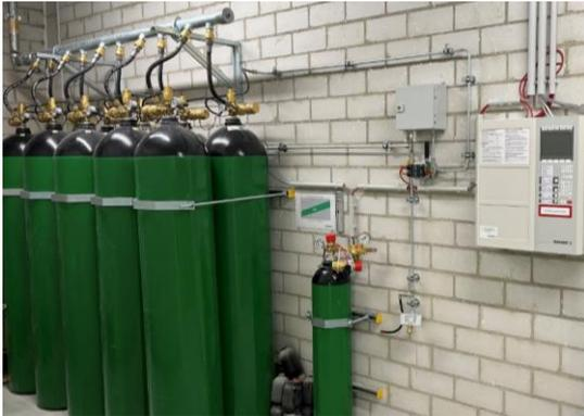
Stickstoff-Löschanlage für das Server-Housing
