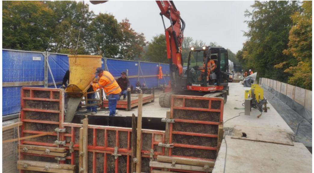
Betonage der nördlichen Kammerwand im Bauabschnitt 2
