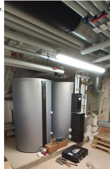
Neue Pelletheizung mit 48 kW Leistung
