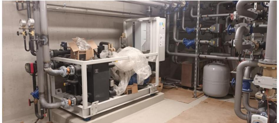
CO<sub>2</sub>-Kältemaschine als Redundanz zur Brunnenkühlung mit 100 kW Kälteleistung
