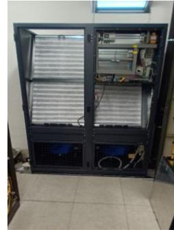
Einer von zwei Präzisionsklimaschränken im Serverraum (redundant)
