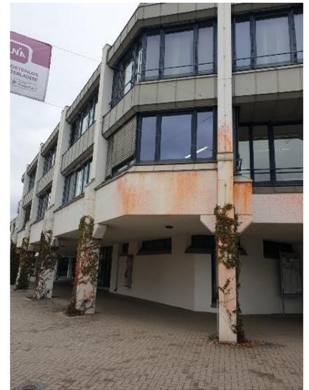
Nach dem Farbangriff durch Klimaaktivisten der „Letzten Generation“ auf das Gebäude A sollte die Fassade saniert werden. Die Schäden wurden unter anderem an der Außenwand, der Drehtür sowie den Fensterrahmen und -scheiben, auf dem Pflaster und an den Stützsäulen beseitigt.
