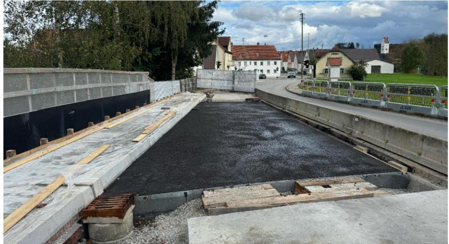
Überbau nach Einbau der Gussasphaltschutzschicht
