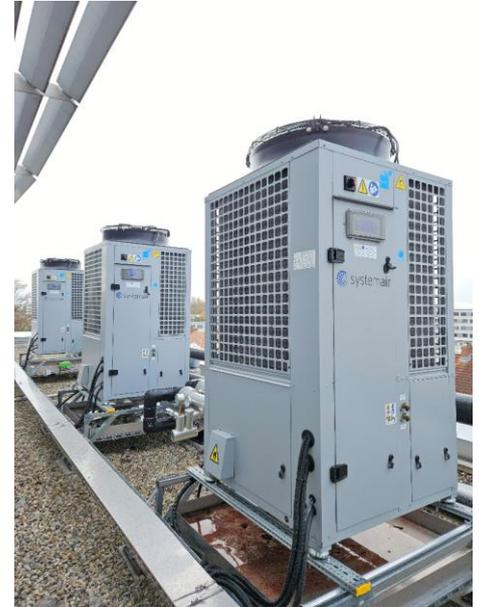
3 redundante Propan-Kältemaschinen auf dem Dach des Präsidiums
