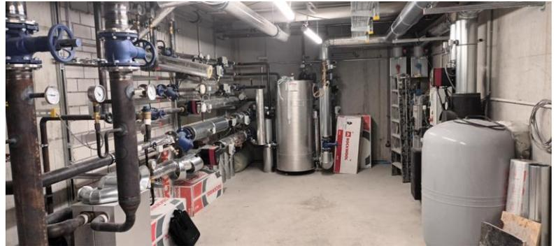
Heizzentrale mit Fernwärmeanschluss 380 kW
