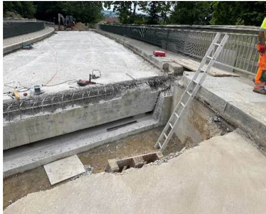
Abbrucharbeiten am Ende des Überbaues
