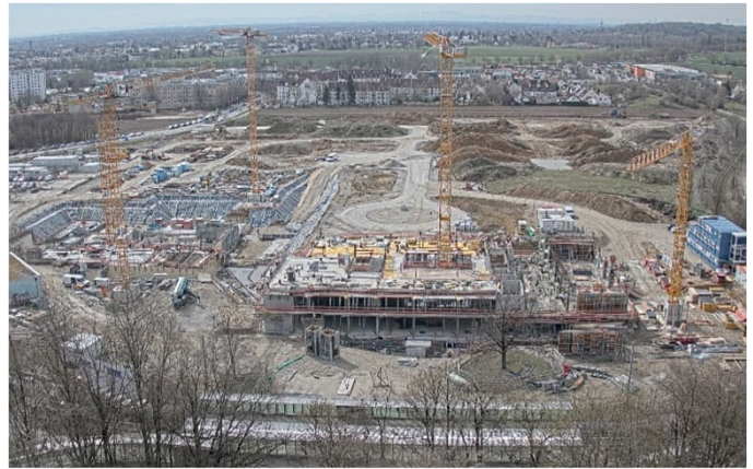
Baustelle im April
