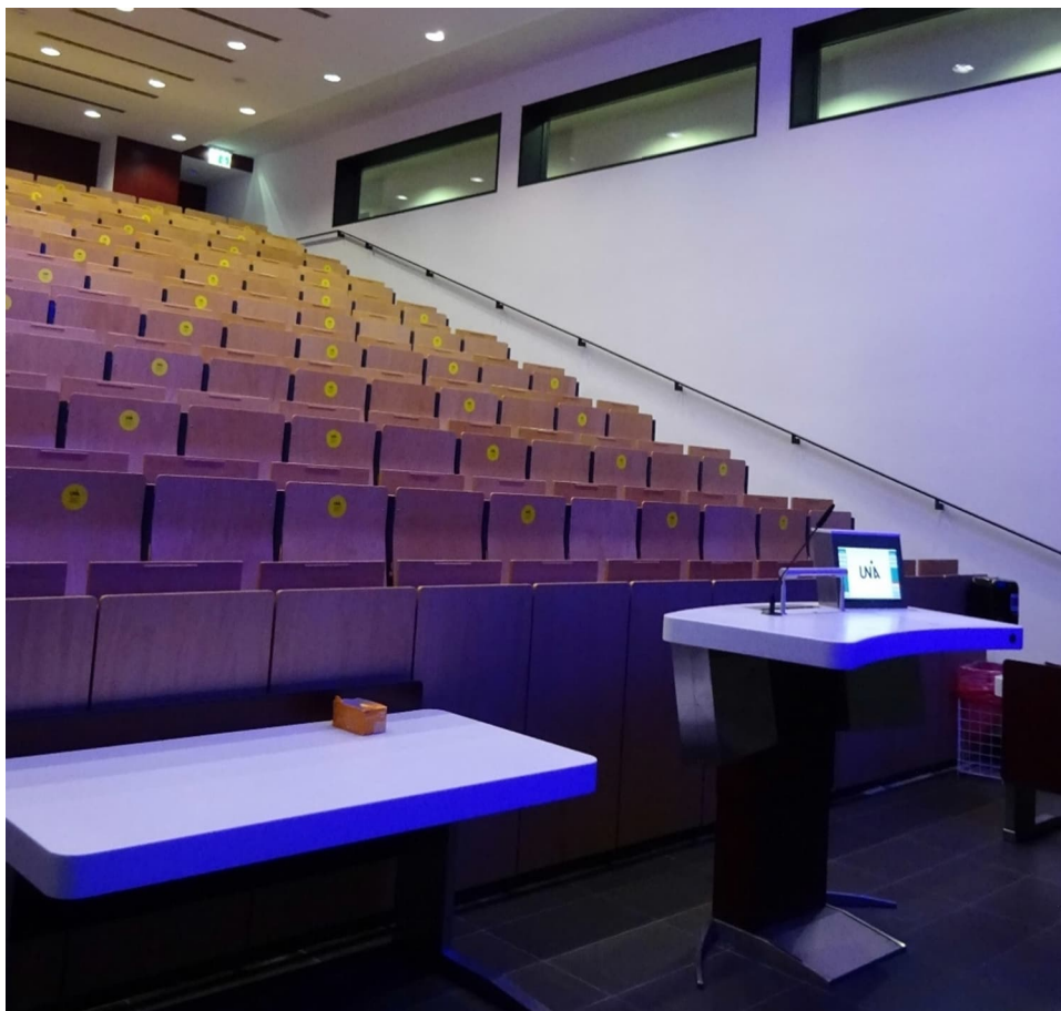
Gebäude N: Modernisierung der medientechnischen Anlage des Hörsaales
