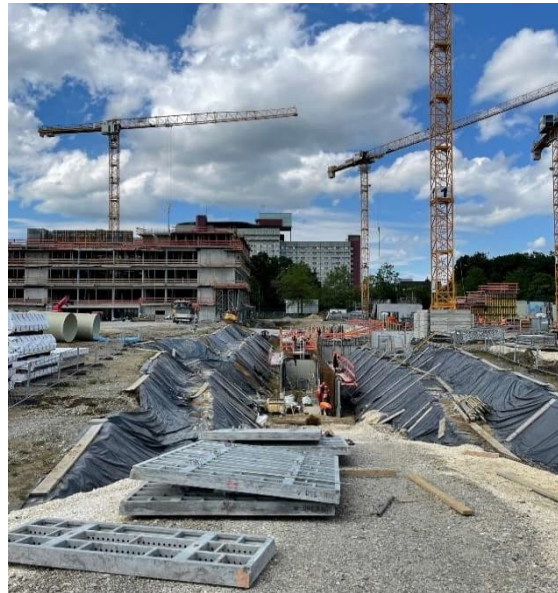
Errichtung des Medienkanals
