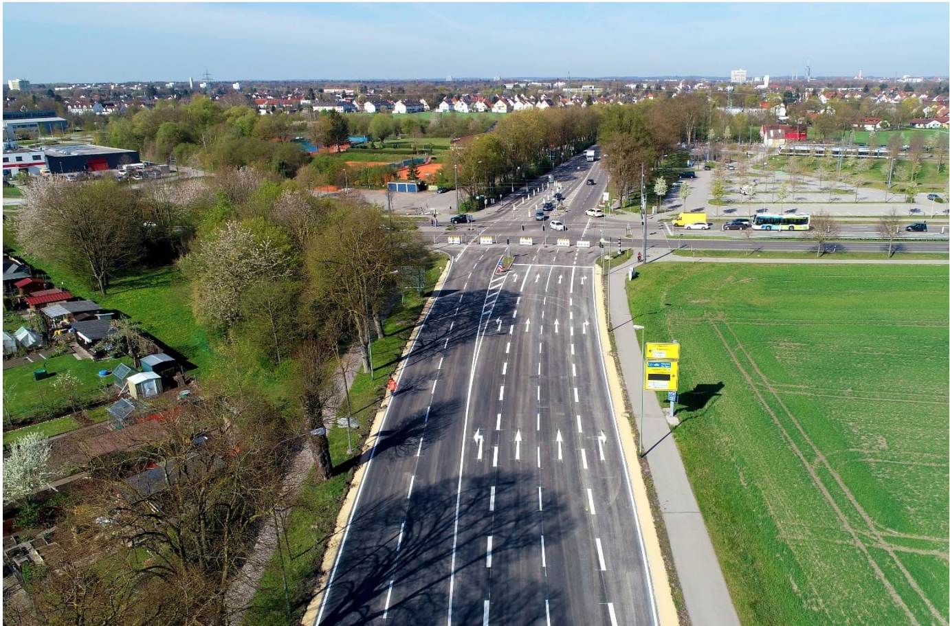
Blick auf den Beginn der Baustrecke kurz vor Verkehrsfreigabe - die entsprechenden Fahrstreifen sind noch abgesperrt.
