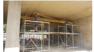
Ausschalarbeiten am Überbau
