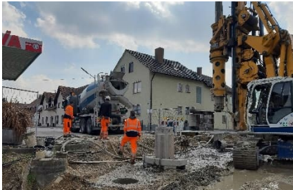
Betonage eines Bohrfahles
