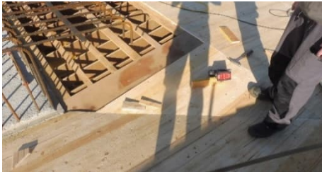
Detail der Überbauschalung
