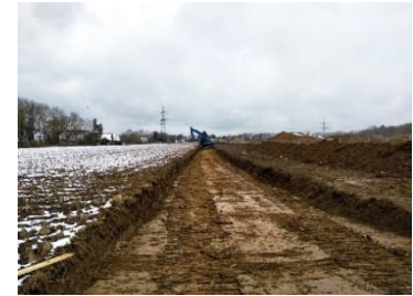
Baubeginn der Delbrückstraße im April ...
