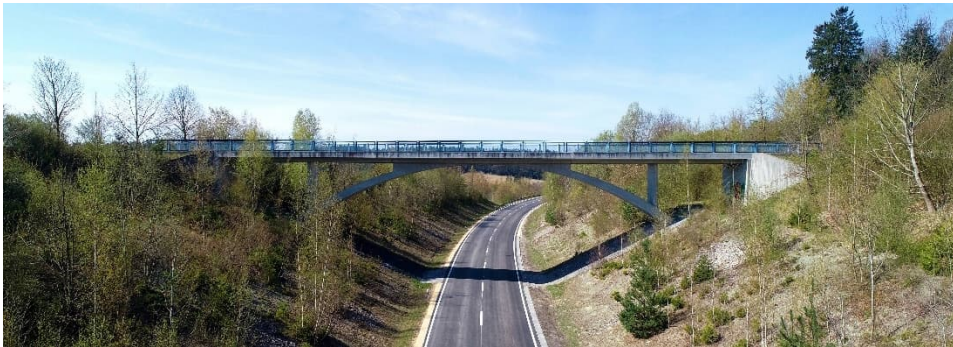
Die neue Fahrbahn im Bereich eines Brückenbauwerks.
