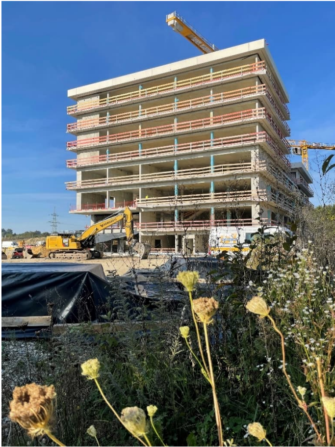
Eindrücke von der Baustelle
