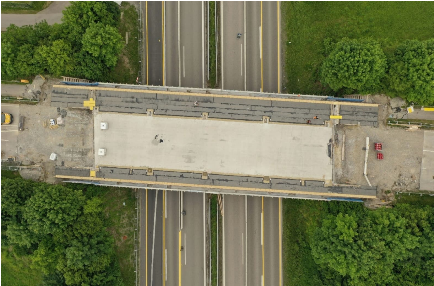
Draufsicht auf die Überführung der Kreisstraße A 30 über die B 17 nach der Abdichtung des Überbaues mit Bitumenbahnen im Bereich der Kappen
