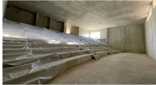
Hörsaal im Rohbau
