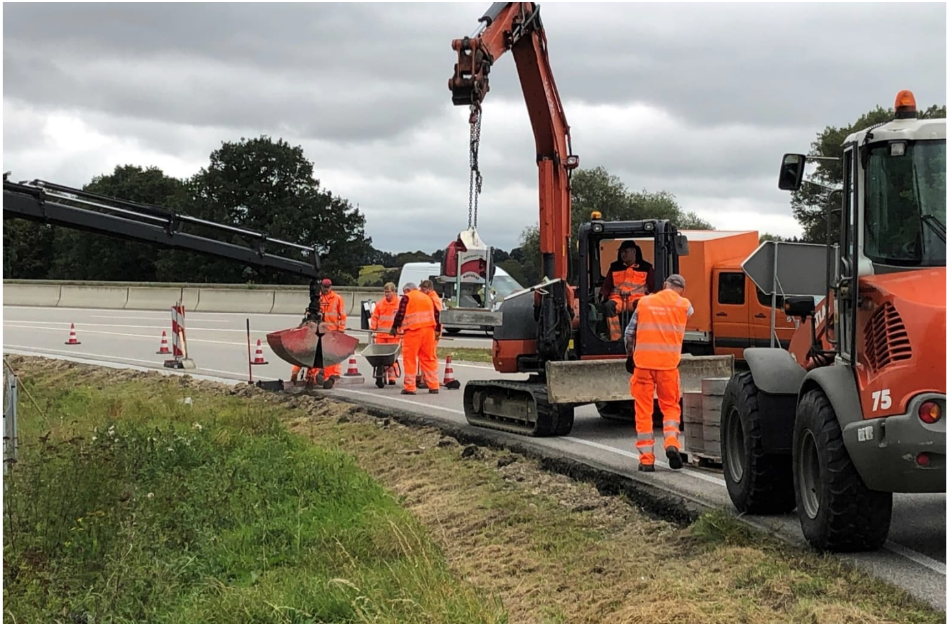
Einbau von Bankettplatten zur Erhöhung der Verkehrssicherheit
