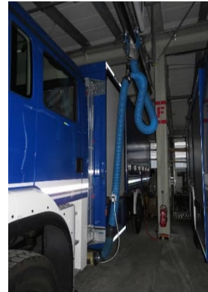
Sauginheit am Abgasrohr MLW
