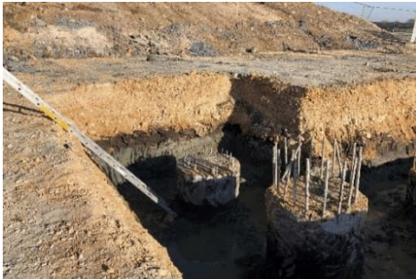
Baugrubenaushub Achse 10
