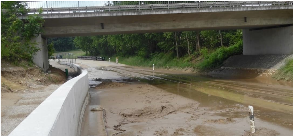
Die Unwetter mit extremen Niederschlägen haben in der Baustelle ihre Spuren hinterlassen.
