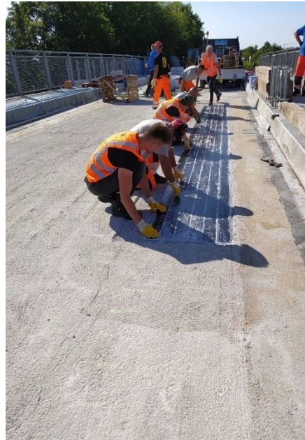
Verstärkung des Überbaues mit CFK-Lamellen
