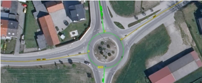
Oben: Einmessen der Nullpunkte nach Deckenbau am Kreisverkehr
