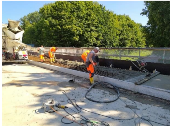
Betonage der verbreiterten südlichen Kappe am BW 7532/522
