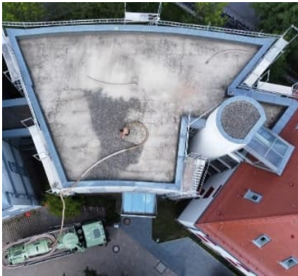
Rückbau Bestand: Absaugen des Kieses
