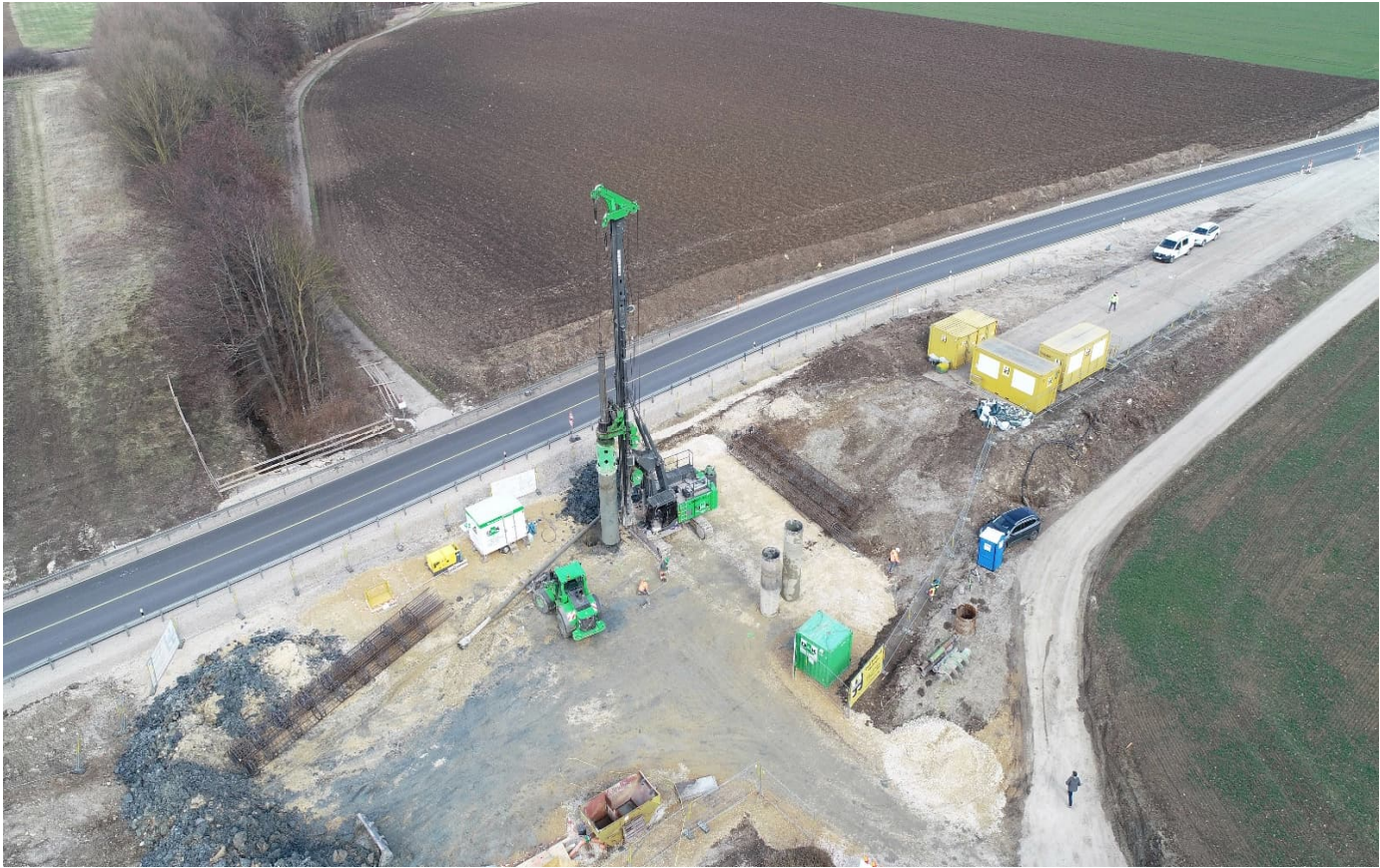
Die B 25 wird während der Bauarbeiten mit einer Behelfsumfahrung um die Baustellenfläche geführt. Auf dem Bild ist das Bohrplan und das Bohrgerät für die Herstellung der Bohrpfähle der Tiefgründung zu sehen. Auf beiden Seiten des Bohrgerätes sind bereits Bewehrungskörbe gelagert, die später vor der Betonage in die Pfähle eingebracht werden.
