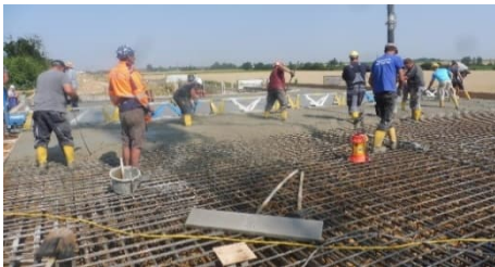
Betonage des Überbaus
