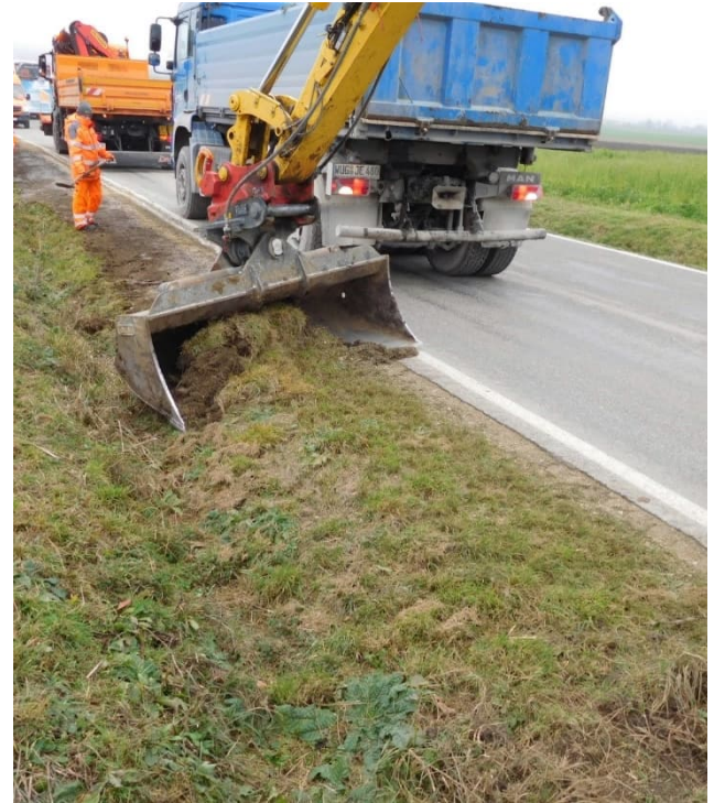
Bankettschälarbeiten, St 2221 zwischen Möttingen und Ziswingen
