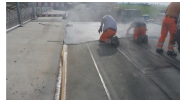
Einbau der Gussasphalt-Schutzschicht
