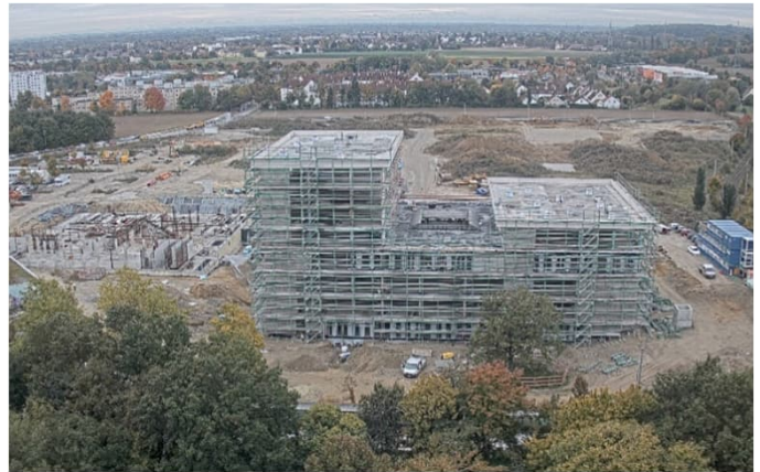
Baustelle im Oktober
