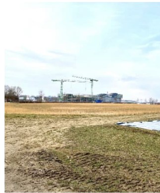
Blick auf das Baufeld
