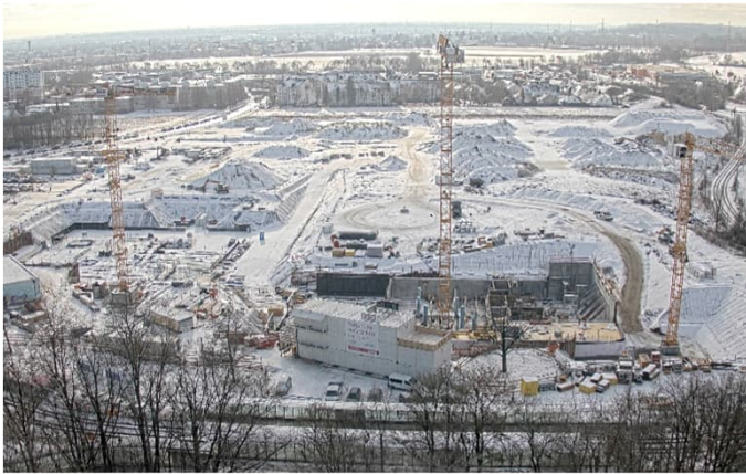
Baustelle im Januar
