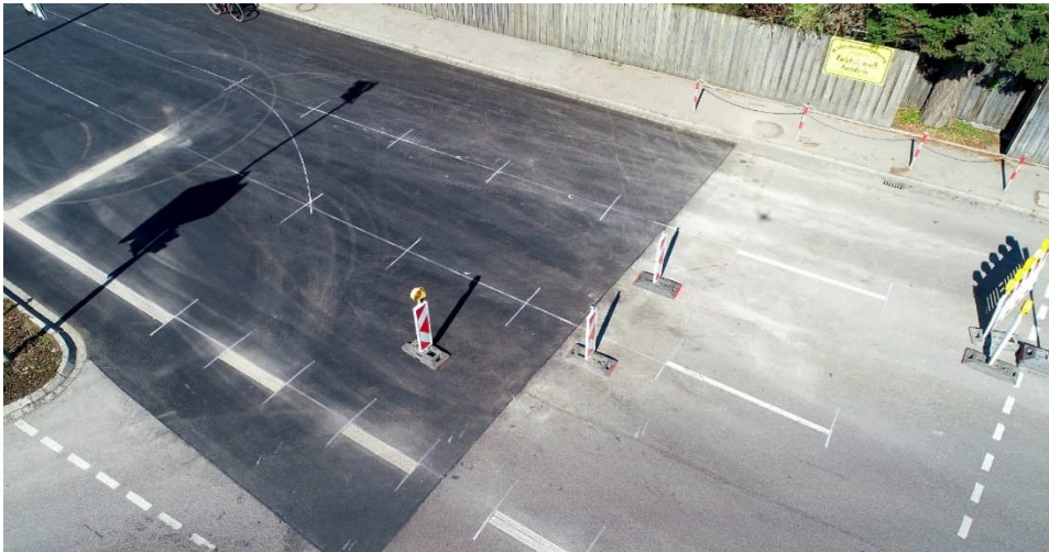
Fertiggestellte Asphaltfläche mit Vormarkierung, teils bereits mit der endgültigen Markierung.
