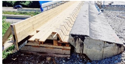
Schalung der Kappenverbreiterung
