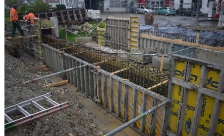
Schalung und Bewehrung eines Widerlagers
