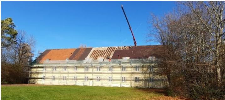
Unterkunftsgebäude LFK: Dachsanierung
