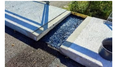
Asphaltübergang im Bau
