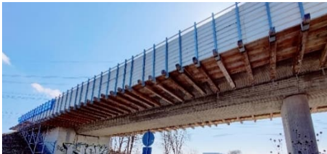
Traggerüst am Überbau
