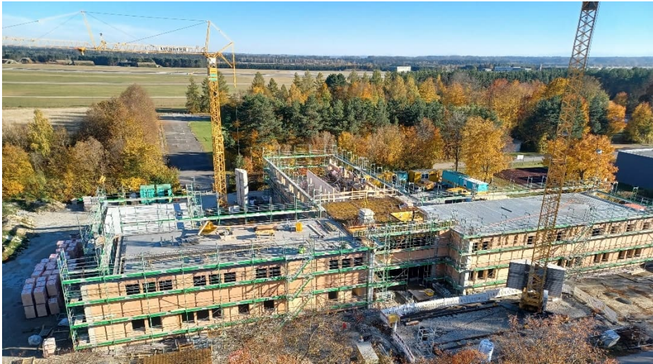
Gesamter Gebäudekomplex aus der Vogelperspektive
