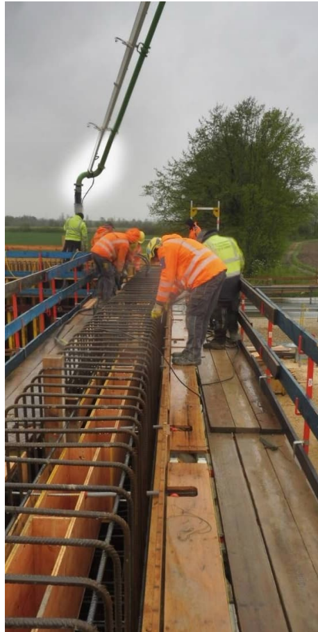
Betonage des Widerlagers in Achse 10
