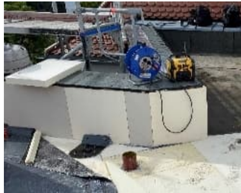
Arbeit am neuen Dachaufbau: Dämmen und Abdichten
