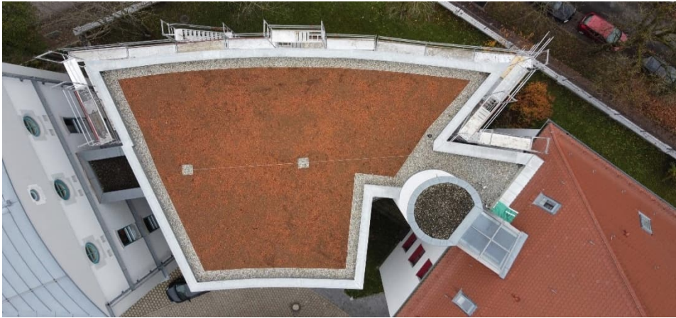
Flachdach nach Erneuerung
