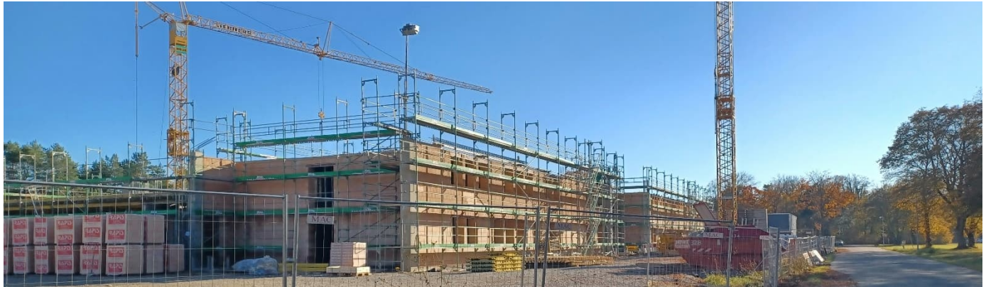
Nord- / Westansicht - Baustelle
